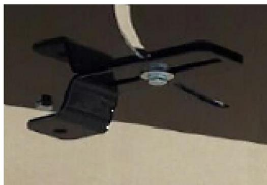
vista inferiore - sistemi di fissaggio del proiettore
